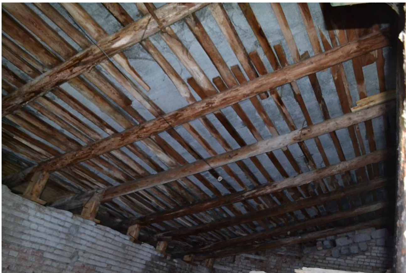
Фото 3. Стропильная система. Общий вид. Подпорки стропил.
