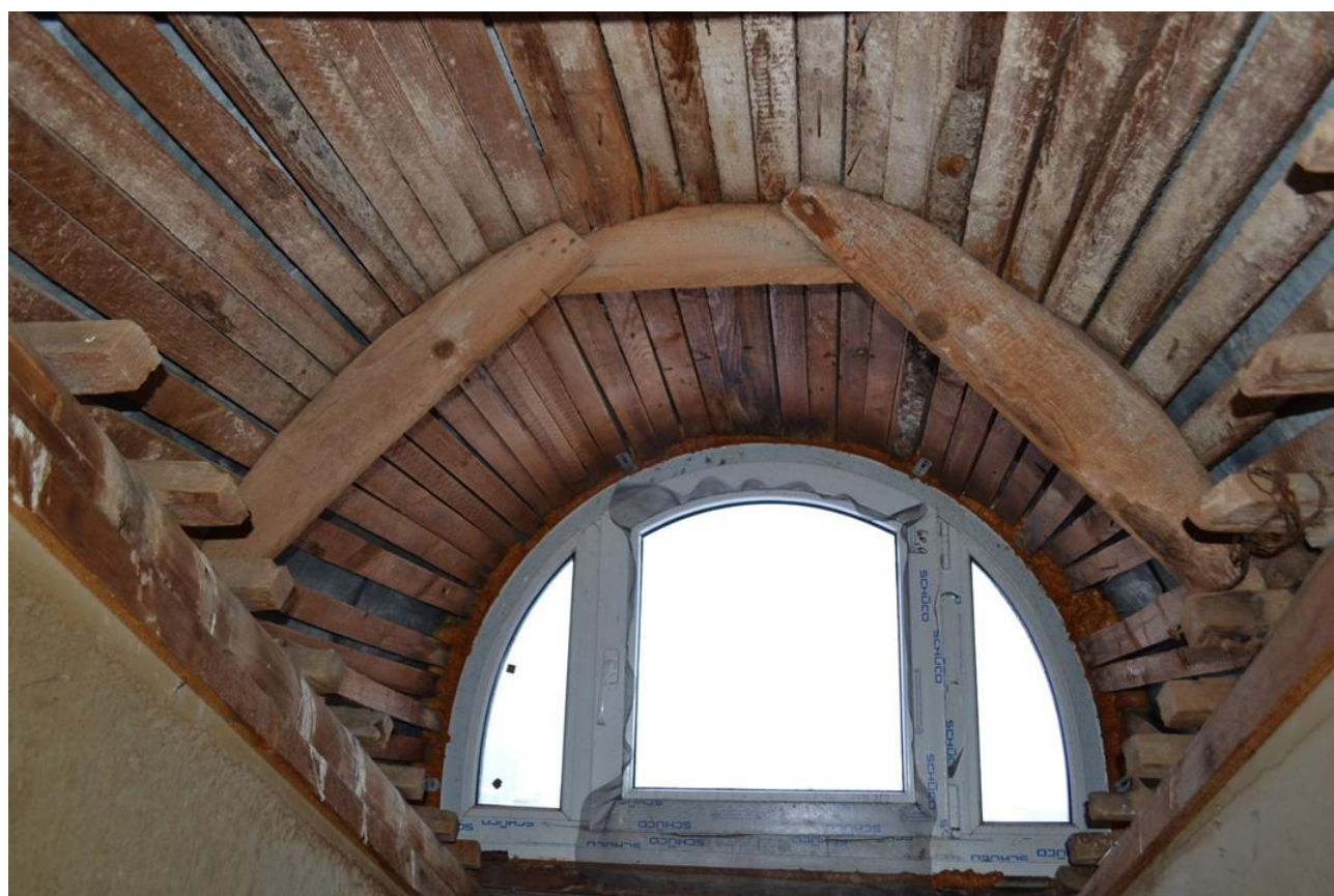
Фото 6. Слуховое окно выхода на кровлю.
