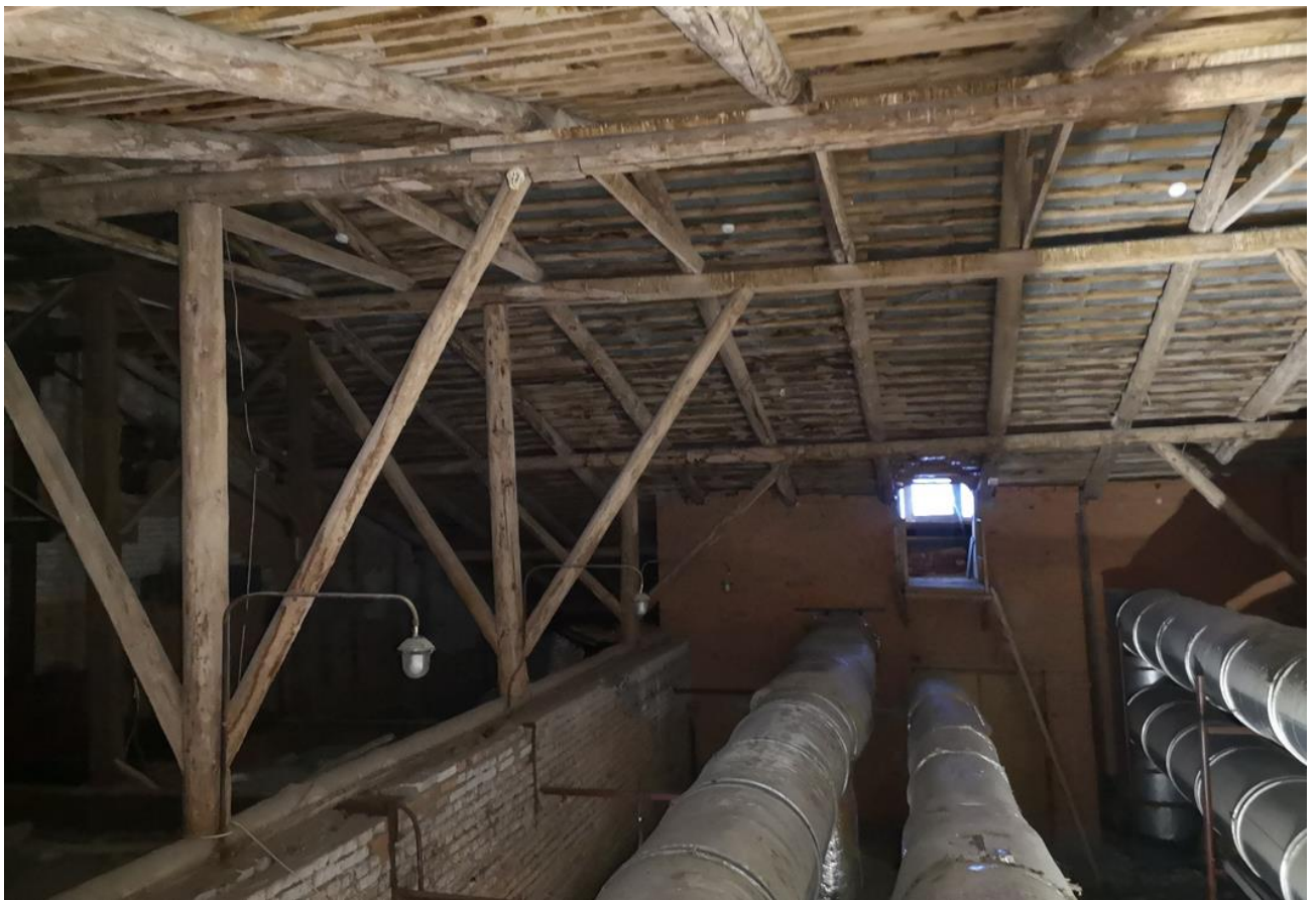
Фото 16. Стропильная система кровли. Общий вид.
