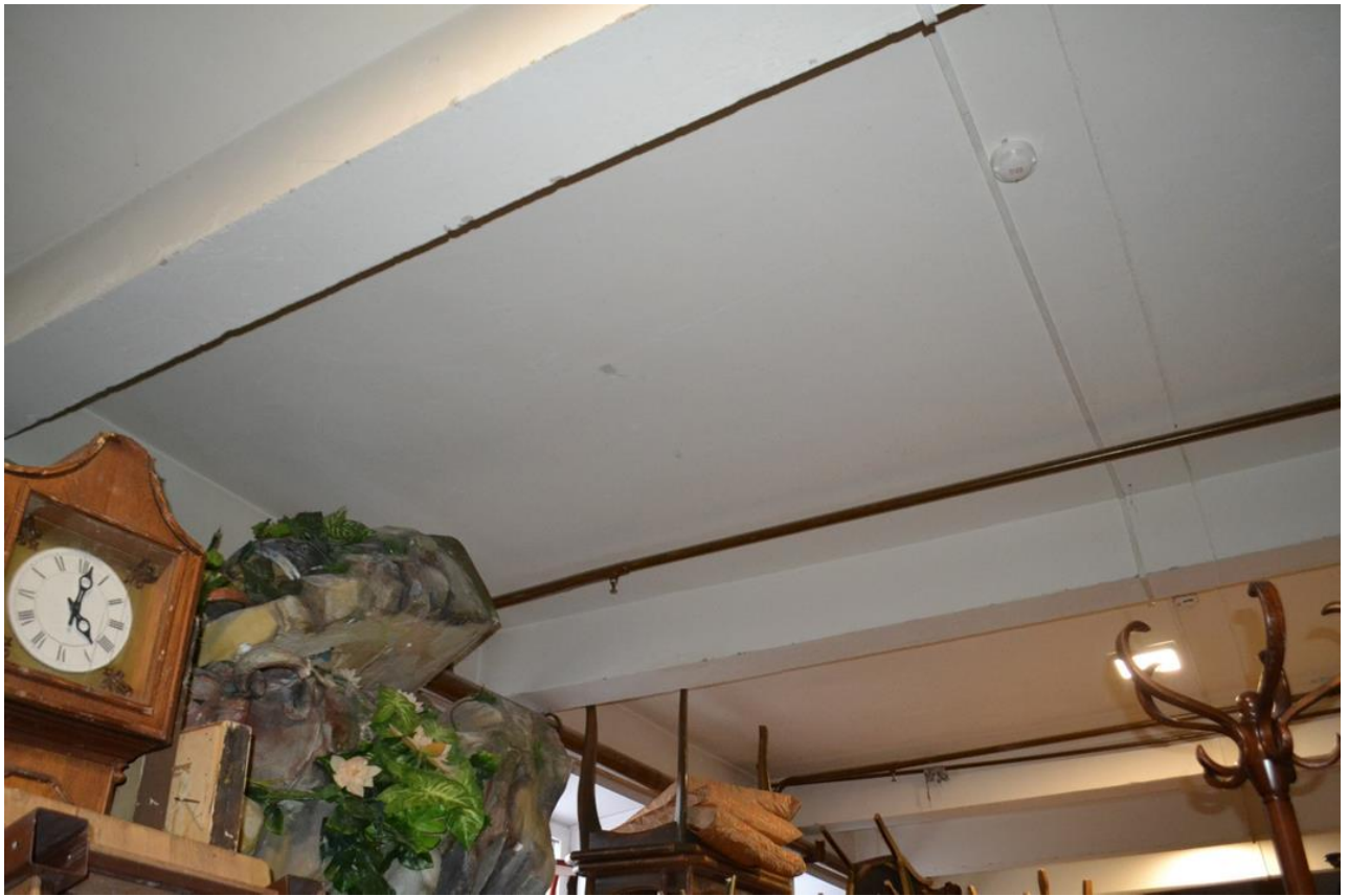
Фото 13. Чердачное перекрытие под помещением в осях 12-13/Д-Л.
