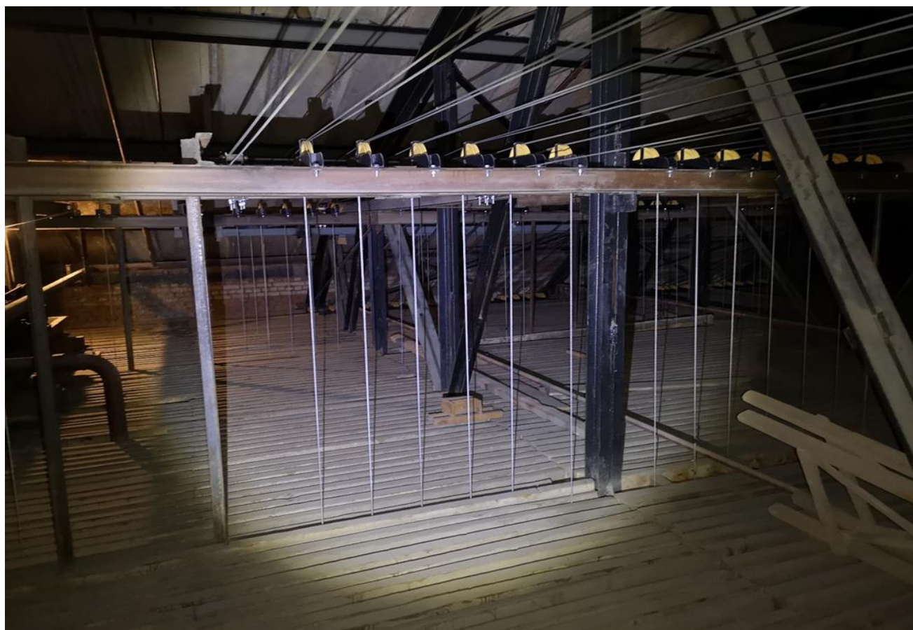
Фото 18. Помещение рабочей галереи.
