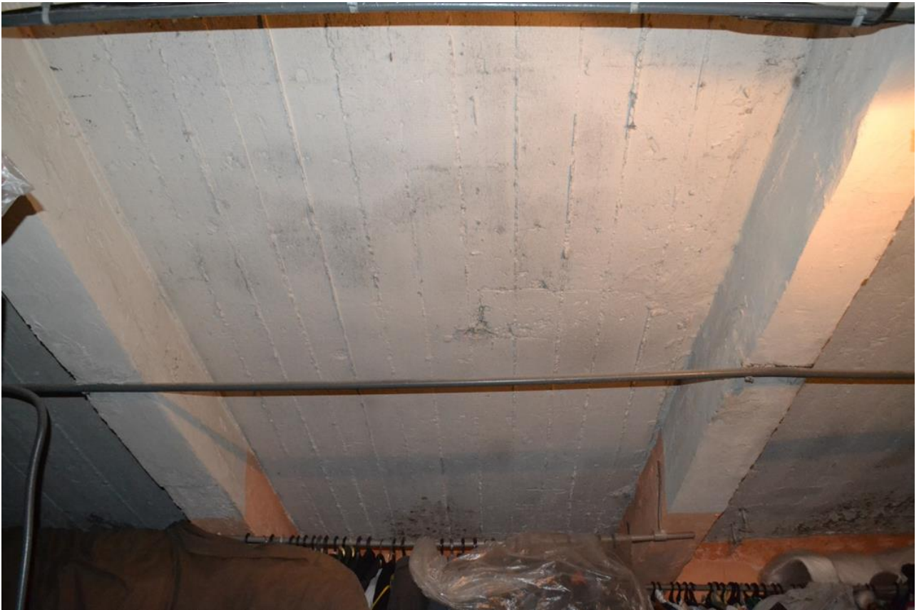
Фото 14. ЖБ перекрытие над калориферной.
