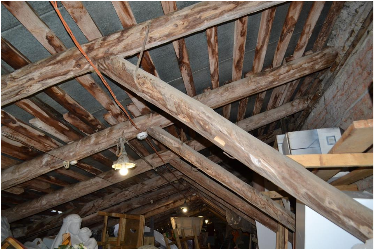
Фото 15. Чердачное помещение в осях 12-13/Д-Л.
