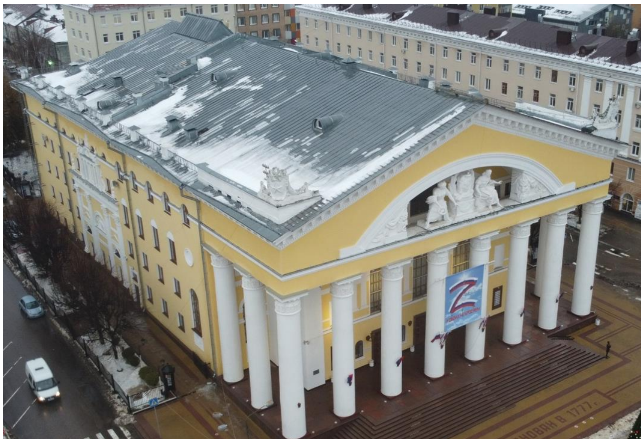
Фото 1. Кровля здания. Общий вид.
