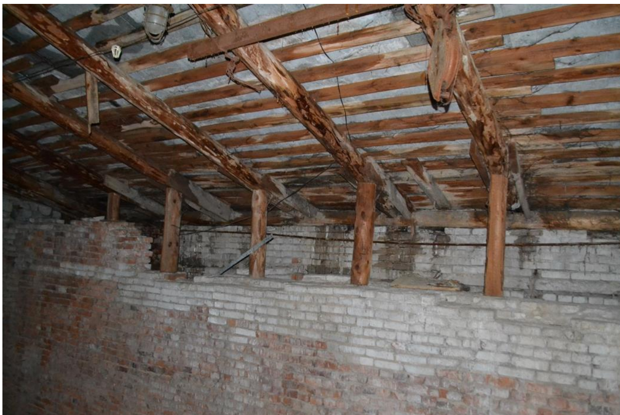
Фото 7. Подпорки стропил (зона в осях 1-3).
