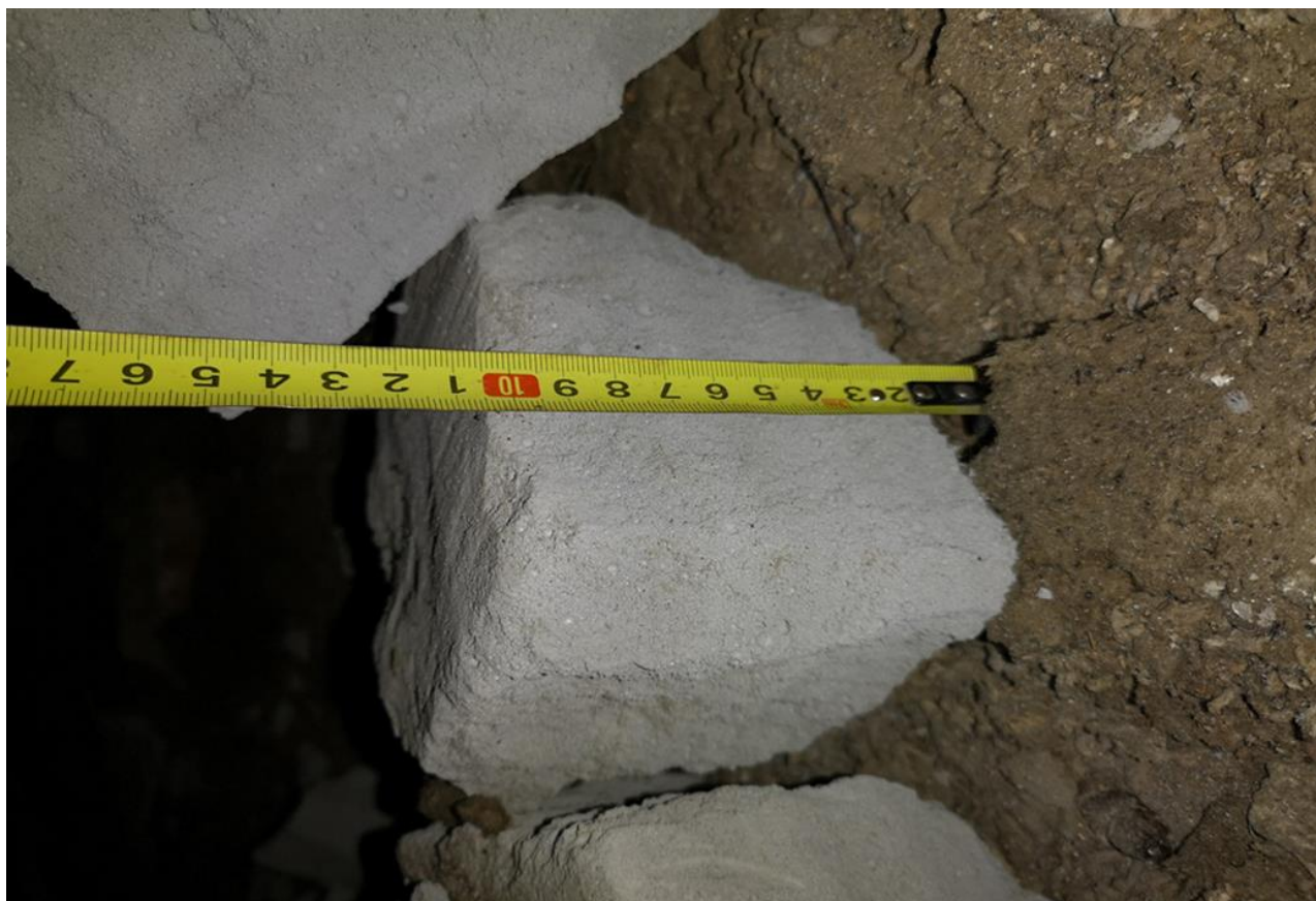
Фото 21. Измерение толщины утеплителя перекрытия над живоп. мастерской.
