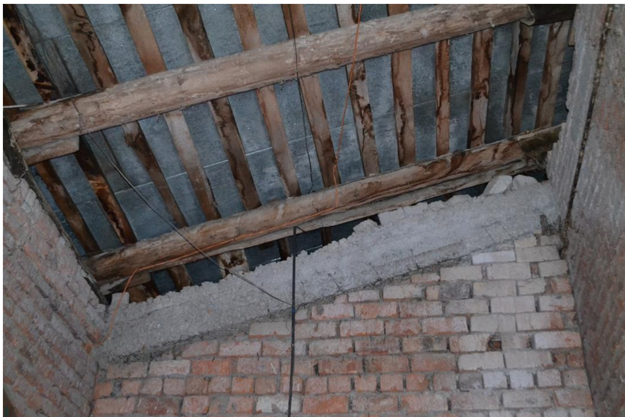
Фото 5. ЖБ перекрытие над некоторыми чердачными помещениями.
