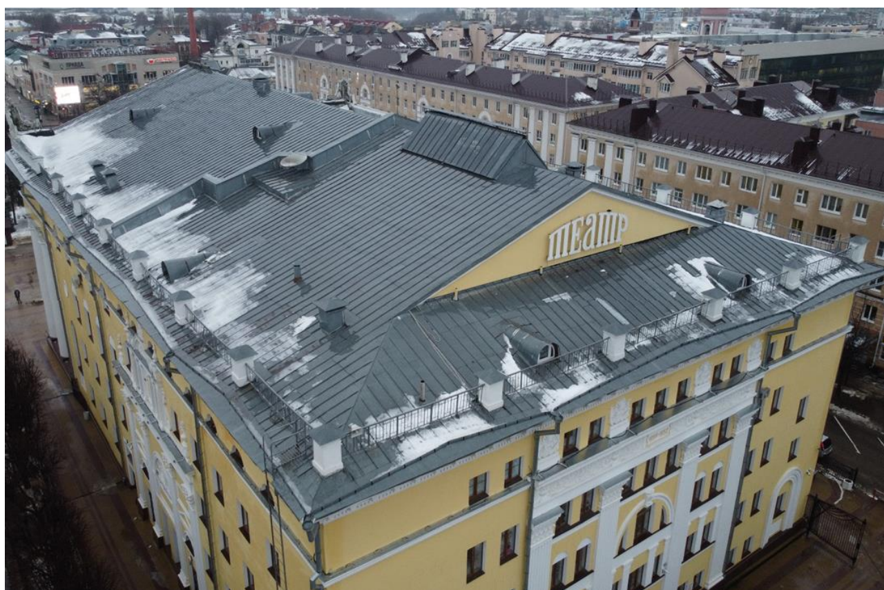
Фото 2. Кровля здания. Общий вид.
